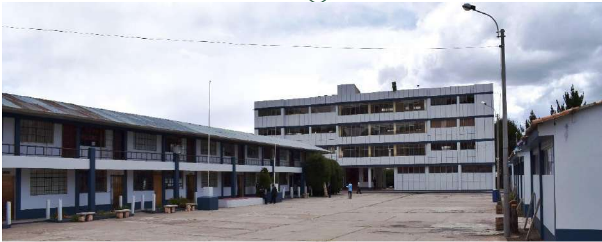
Infraestructura al servicio de la formación Docente
